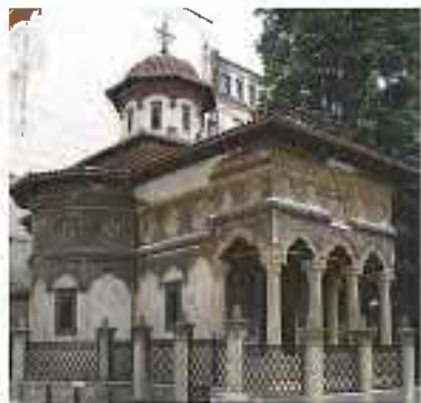
Церковь Ставрополеос, построенная в брынковянском стиле
