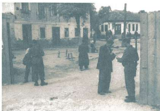
Проверка документов у входа в Кишиневское гетто, 1942 г.
