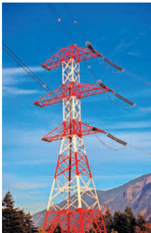
Линии высокого напряжения
