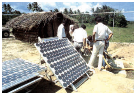
Панели солнечных батарей для перекачки воды
