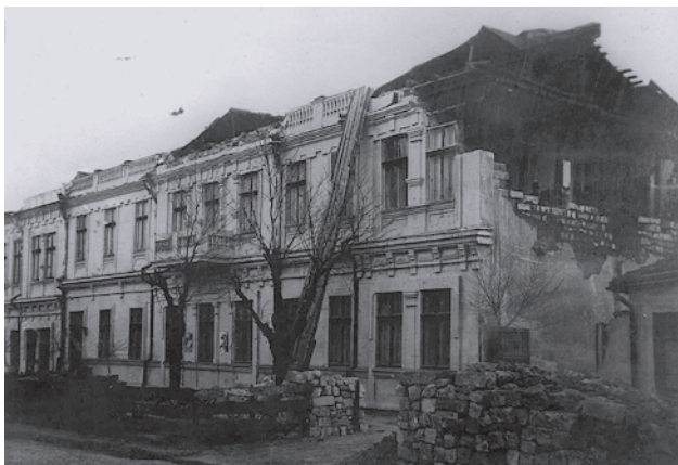
Рис. 20. Здание в Кишинэу, разрушенное землетрясением 10 ноября 1940 г.
