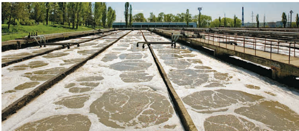
Рис. 101. Очистные сооружения муниципия Кишинэу, производительностью 6 600 м 3 /час
