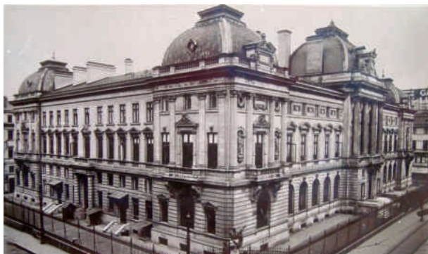
Дворец Национального Банка. Здание построено по проекту французских архитекторов А. Галерона и К. Бернарда
