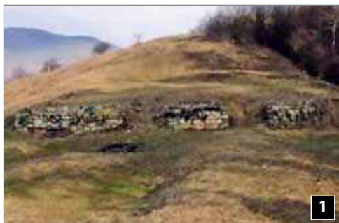
Каменная постройка в Орхеюл Векь
