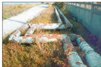
3.16. Компенсирующая петля теплотрассы
