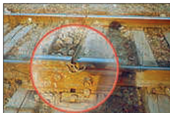
3.15. Зазоры между железнодорожными рельсами
