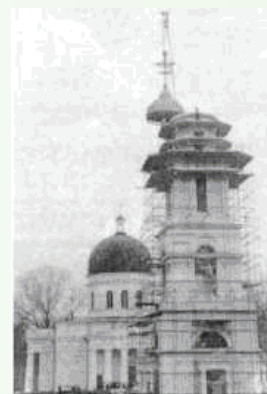
Реставрация Собора Рождества Христова. Восстановление звонницы разрушенной коммунистами в 1962 г.
