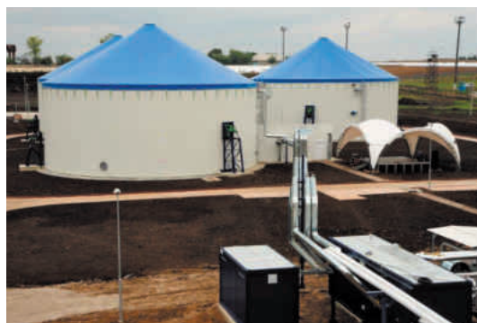
Рис. 3.46. Установки по производству биогаза на сахарном заводе в г. Дрокия
