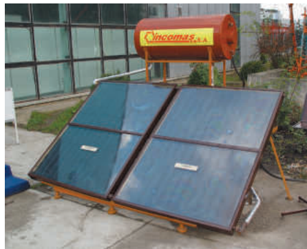
Рис. 3.54. Водонагревательные солнечные батареи — продукция Кишиневского завода Incomaş
