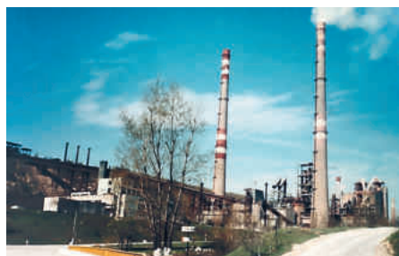
Рис. 3.57. Цементный завод в Резине
