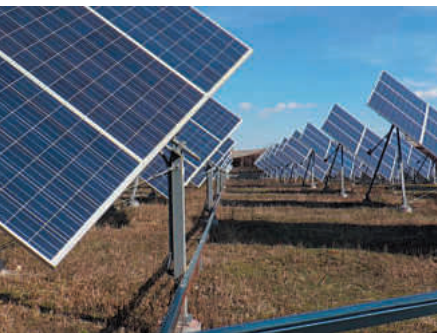
Рис. 1.13. Солнечная электростанция в г. Унгень
